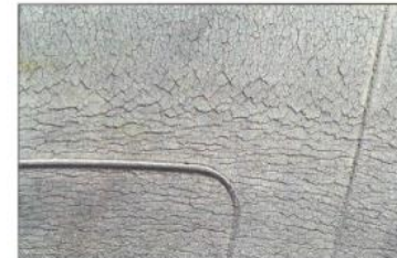
FIGURA 8.a) Agrietamiento
