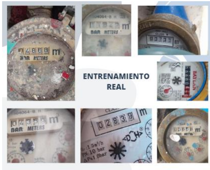
Figura 31. Medidor de agua potable
