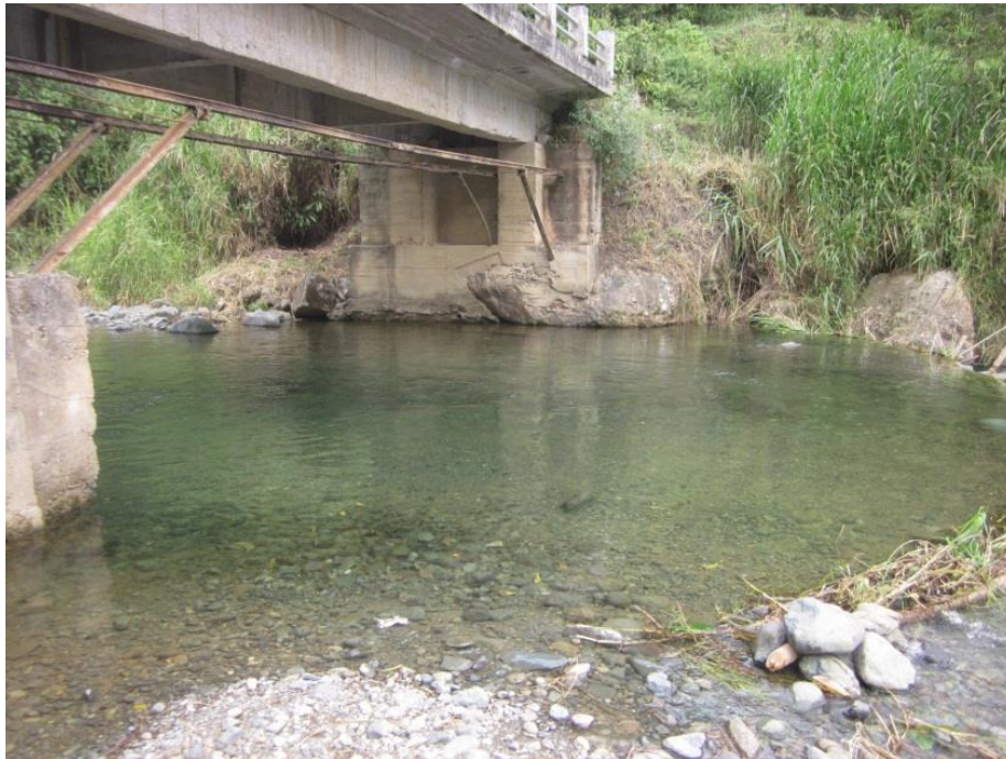
Fotografía 23: Construcción del puente en el Río Verde
