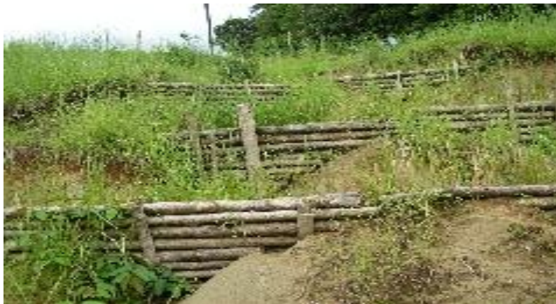
Figura 8: Diques de contención Fuente: Cruz, J. (2009).
