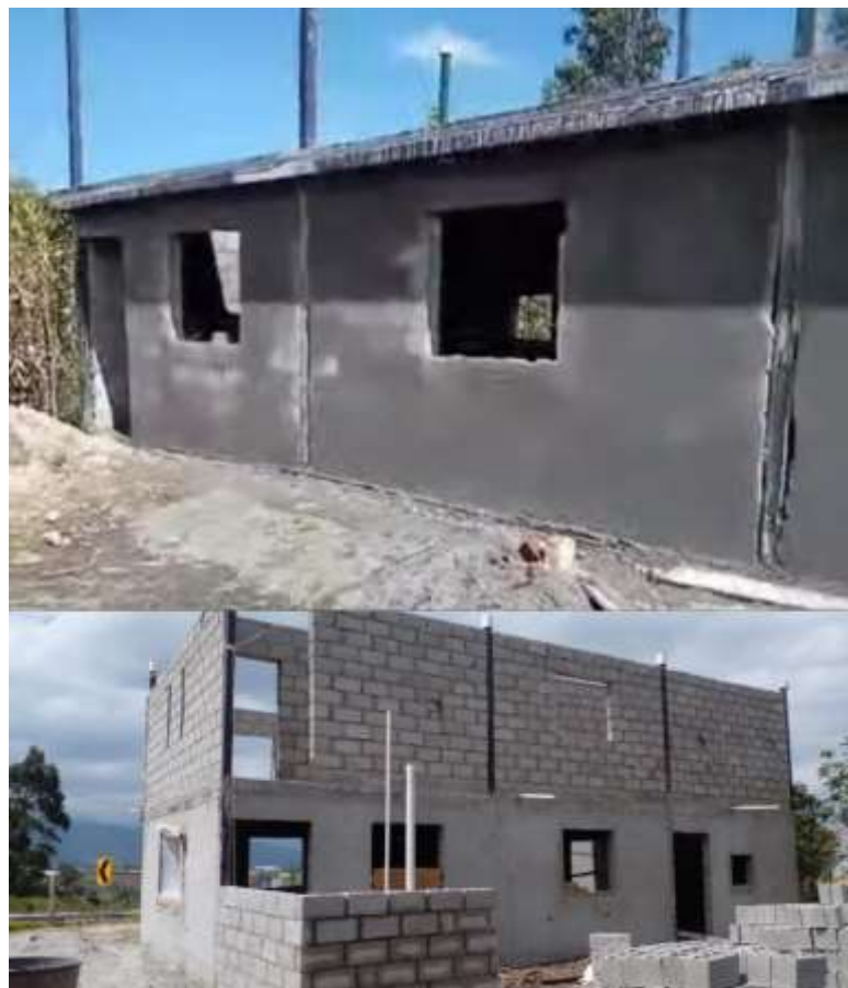
Figura 47. Construcción de planta baja y primer piso del hospedaje
