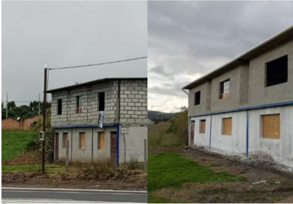
Figura 48. Construcción y enlucido del hospedaje
