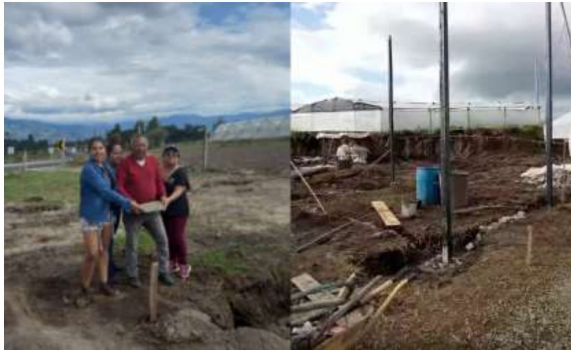
Figura 46. Inicios de la construcción del hospedaje
