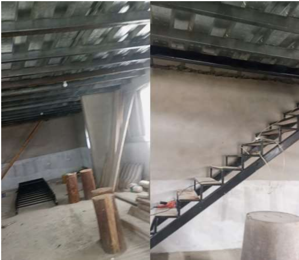
Figura 49. Enlucido interno planta baja y ubicación de la escalera
