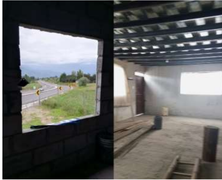
Figura 50. Enlucido interno primer piso del hospedaje
