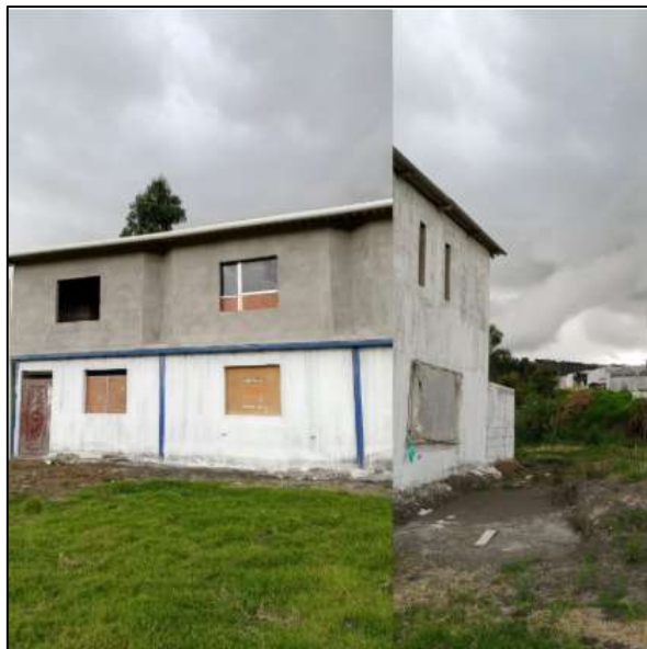
Figura 27. Construcción de hospedaje turístico.
