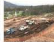
TRAMO. Aún no está lista la vía.
